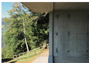
Dépendance à Caux
