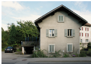
Transformation d'une maison villageoise
